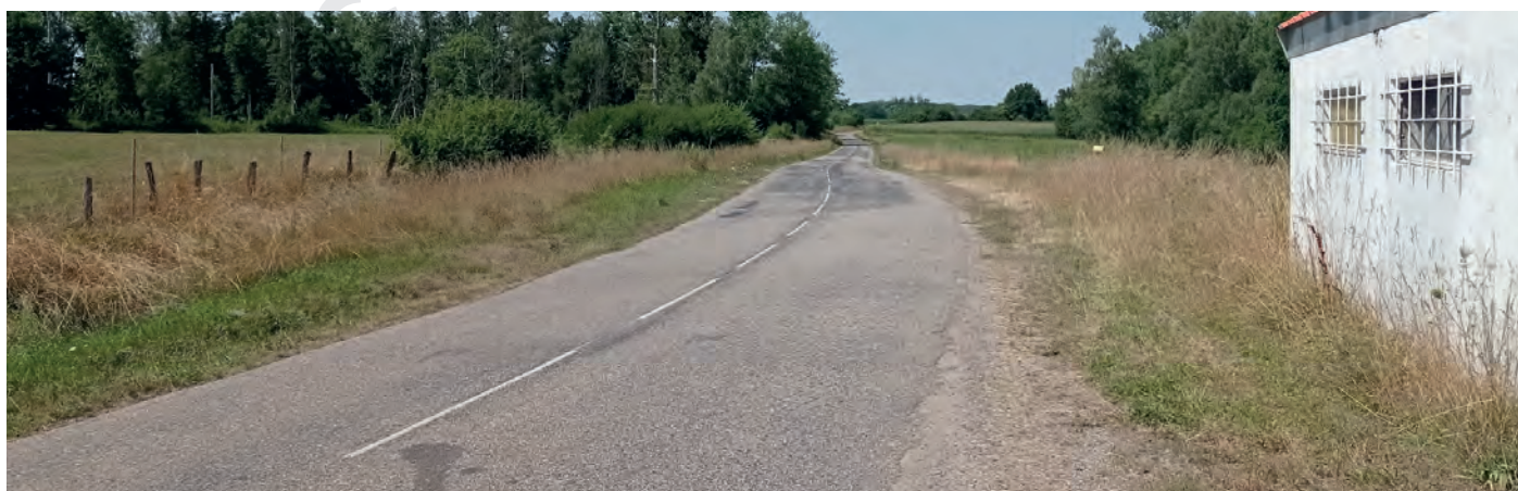
Le territoire est traversé par deux routes départementales : RD400 (photo du haut) et RD19a (photo du bas)
